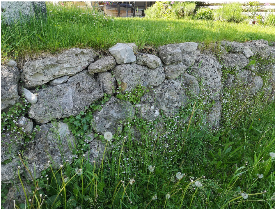
Abbildung 4: Unverfugte Steinmauer am westlichen Rand des Eingriffsbereichs.
